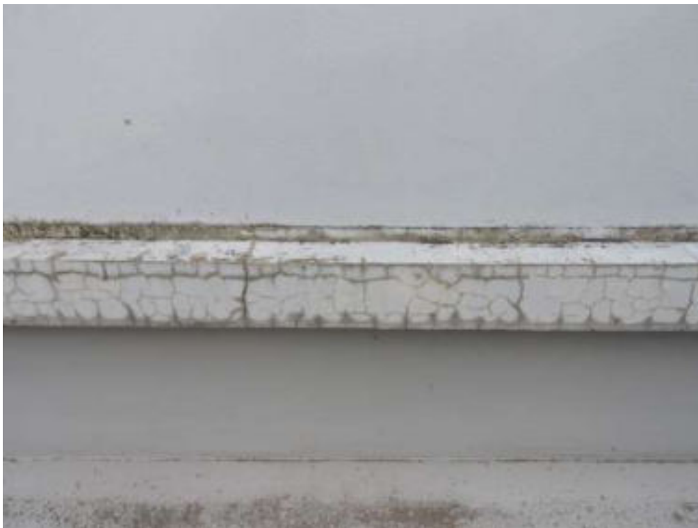
笠木部分防水工事、下地調整箇所（一部抜粋）
