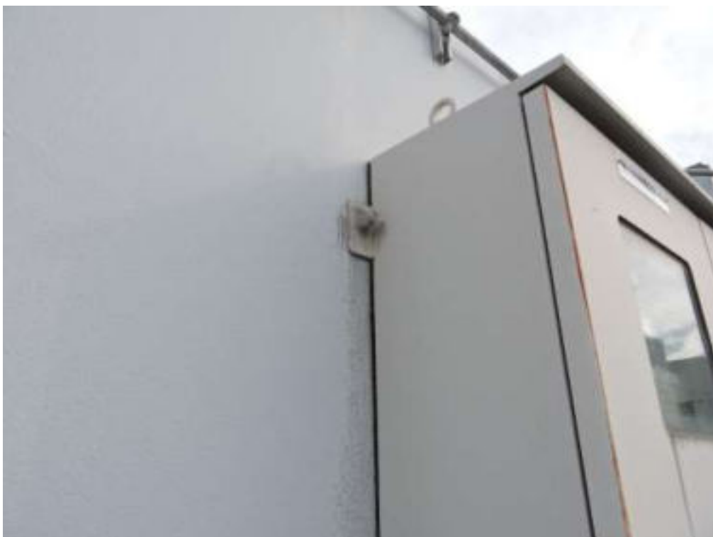
分電盤廻り部分シーリング工事（一部抜粋）
