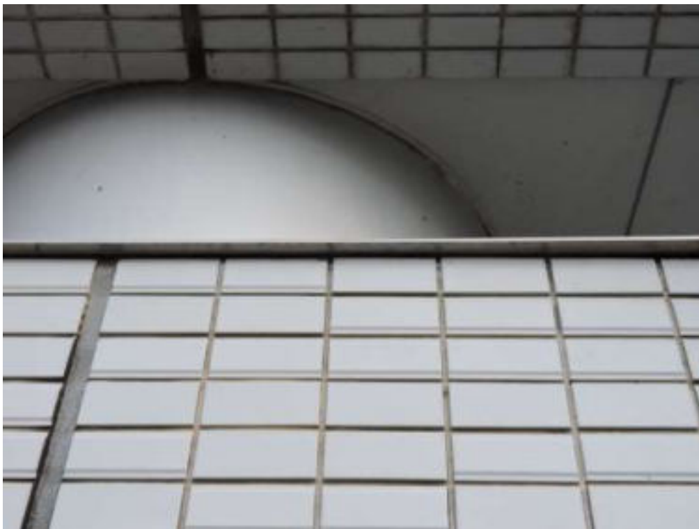
ステンレス見切取合目地シーリング工事（一部抜粋）
