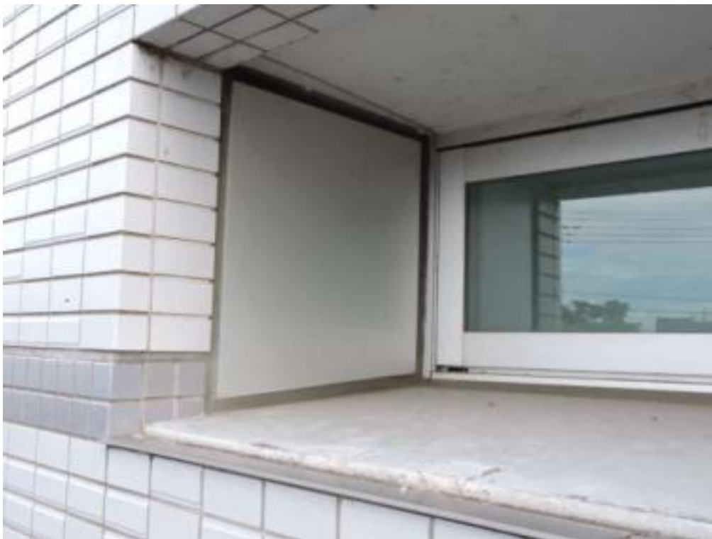
タイル取合部分シーリング工事（一部抜粋）
