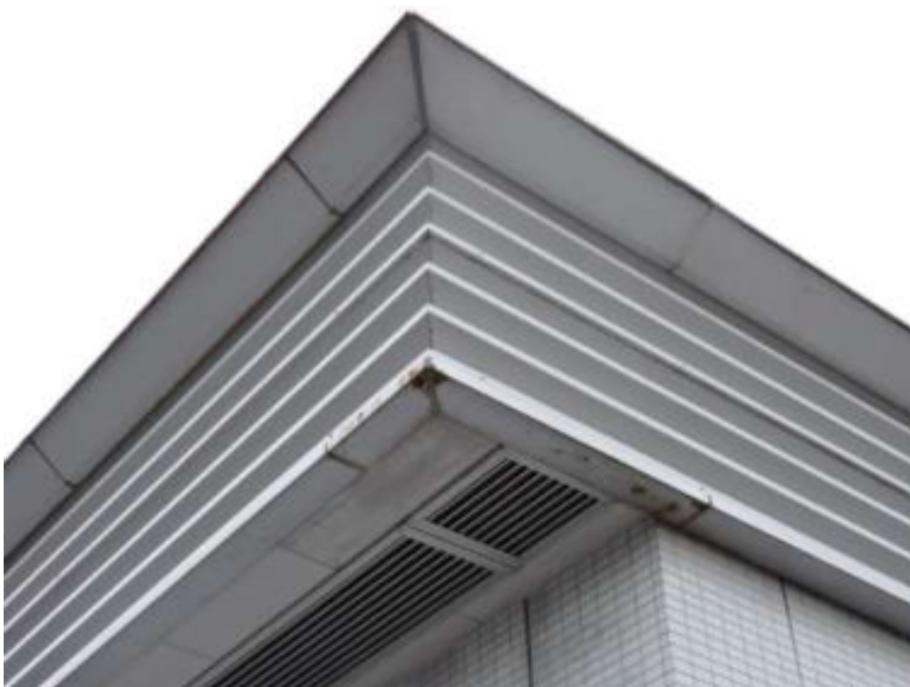
笠木ジョイント・アンダー笠木ジョイント目地部分シーリング工事（一部抜粋）※車庫
