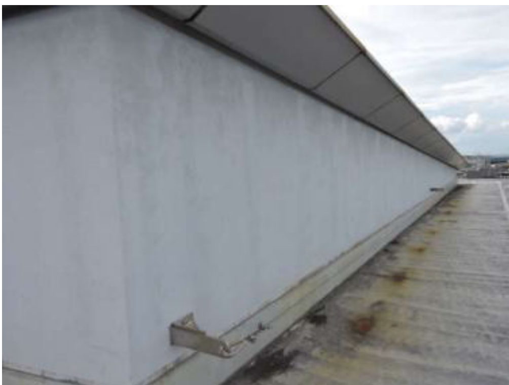
RC 庇上端壁部分塗装工事（一部抜粋）
