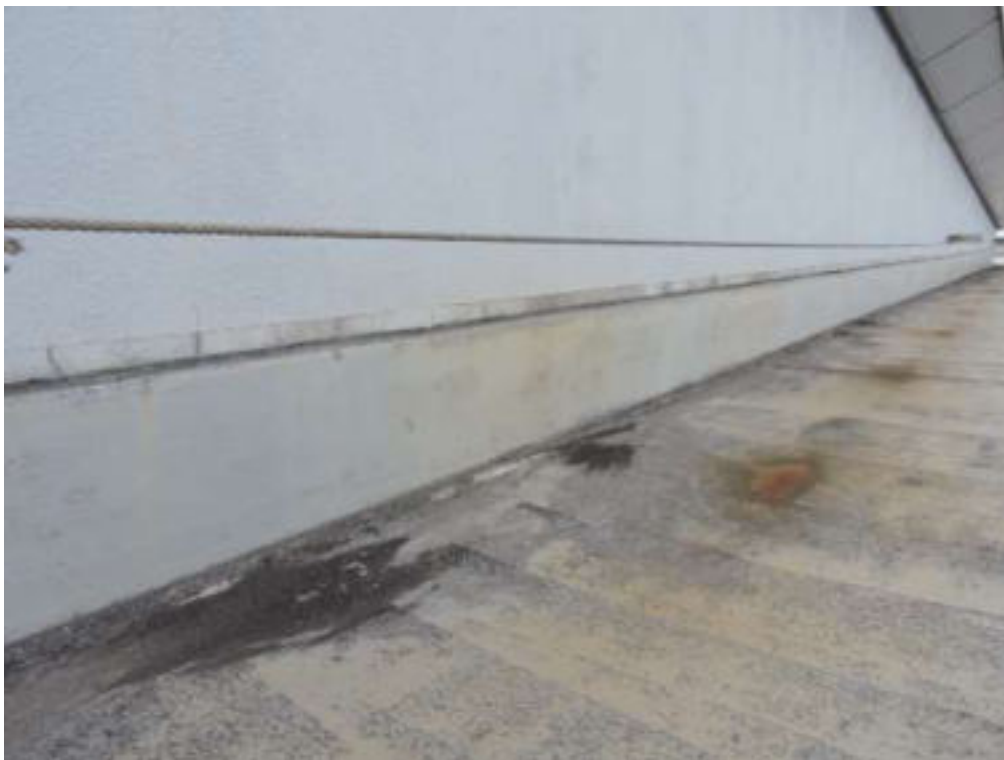
防水立上り目地部分シーリング工事（一部抜粋）
