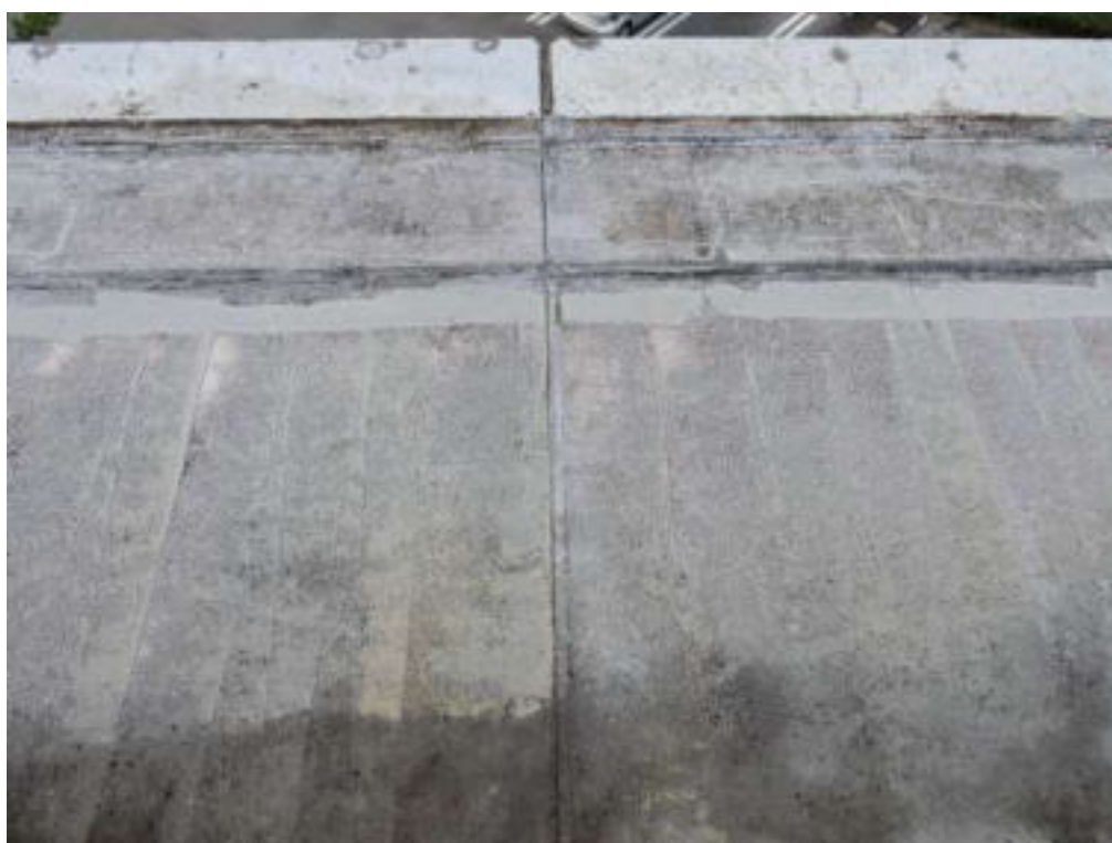
底平場目地部分シーリング工事（一部抜粋）
