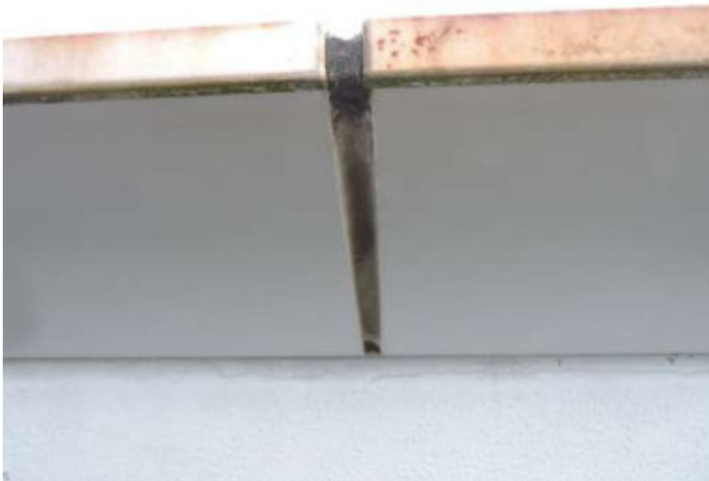
笠木ジョイント目地部分シーリング工事（一部抜粋）
