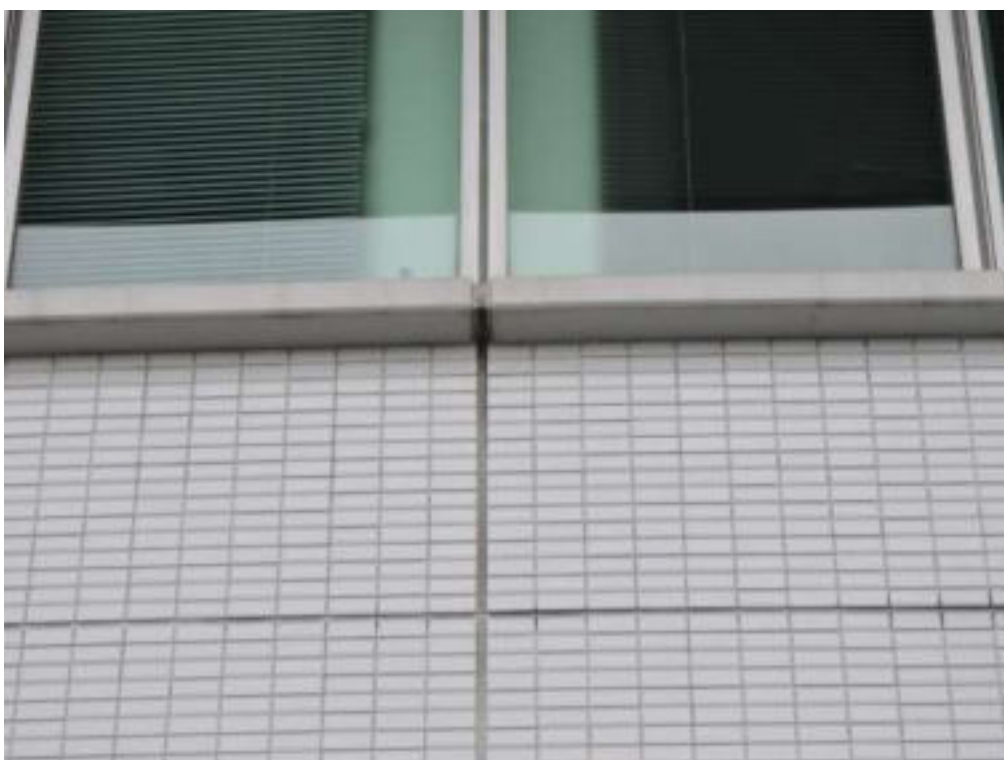
3 階窓下部分塗装工事（一部抜粋）
