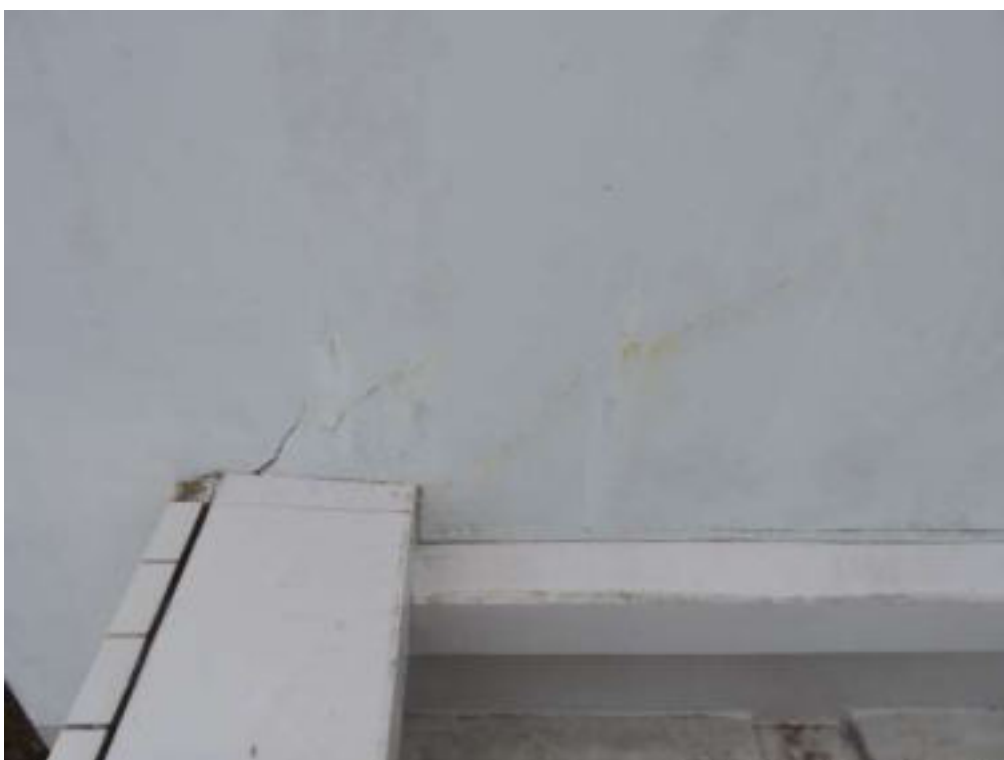
屋上壁部分塗装工事一部ひび割れ補修箇所
