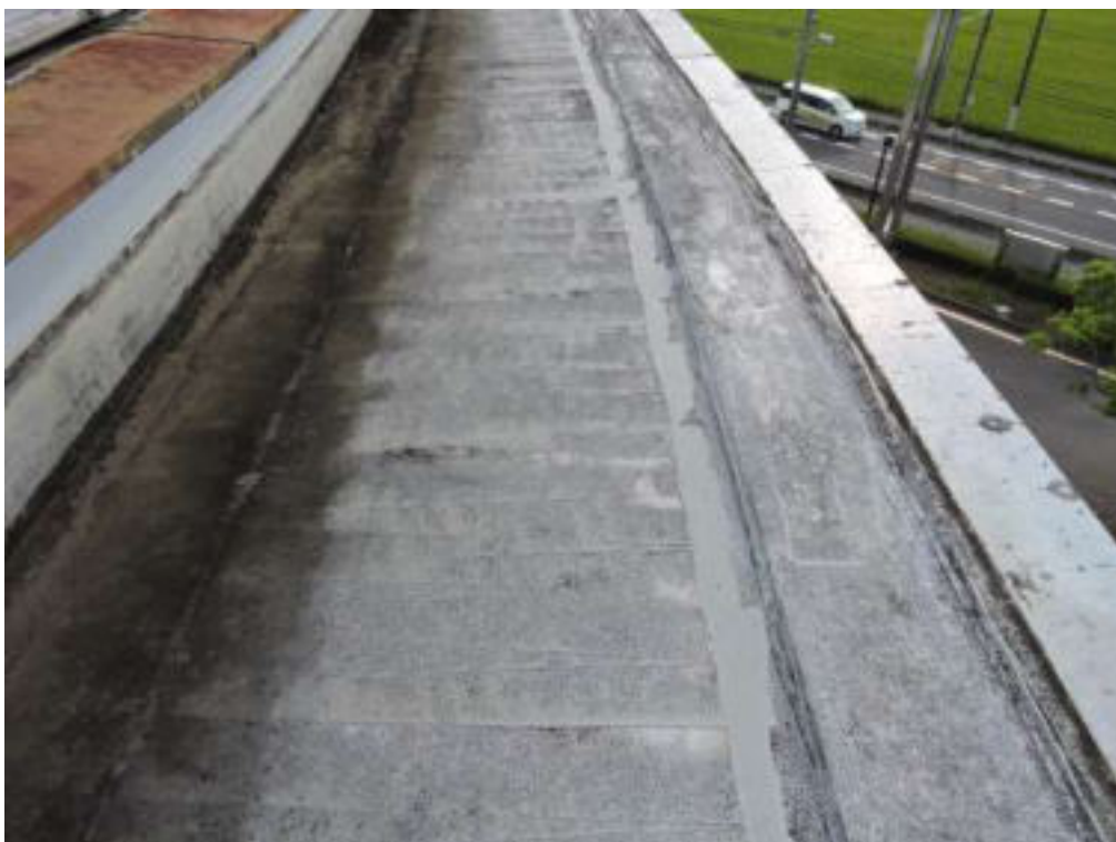
庇平場目地部分シーリング工事（一部抜粋）
